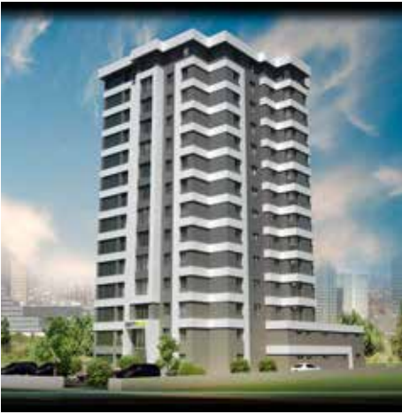
DIŞ CEPHE MONTALAMA
